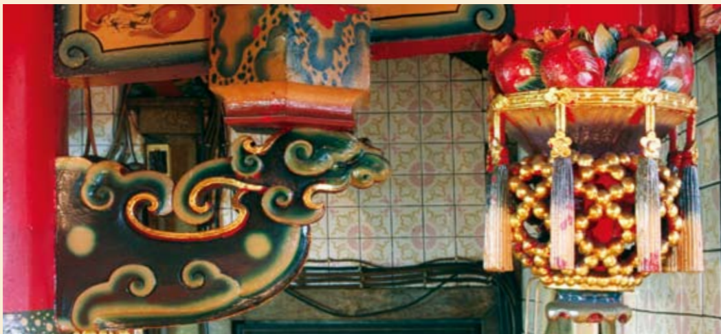
■出簷斗拱以螭虎拱頂斗承吊筒形式
